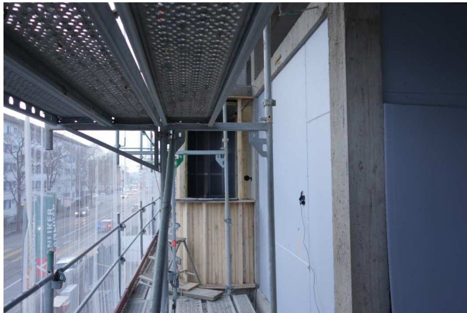
Abbildung 1: Erker Mock-up mit dem Erkermikrofon und dem Referenzmikrofon in Grenzflächenmontage.
