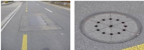
**Abbildung 3:** Beispiele für einen eckigen Plattenschacht auf einem lärmarmen Belag (links) und einen runden Schachtdeckel auf einem herkömmlichen Belag (rechts).
