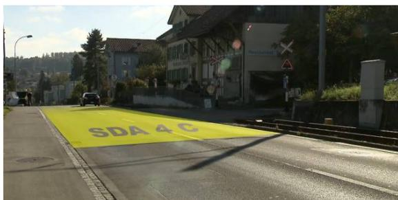
**Abbildung 1:** Belagsübergang eines herkömmlichen Strassenbelags auf einen lärmarmen SDA 4C Strassenbelag in Beinwil am See (Schweiz).
