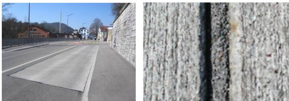
**Abbildung 4:** Betonelemente an einer Bushaltestelle (links) und eine vergrößerte Fuge zwischen zwei Betonelementen (rechts).
