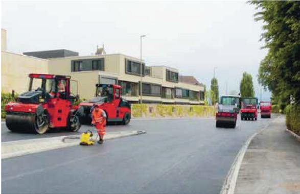
**Abb. 4:** Einbau eines lärmarmen Belages (Quelle: TBA ZH)
