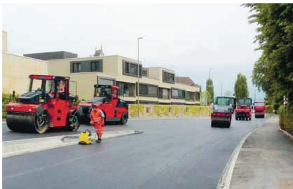
Fig 5: Mise en place d'un revêtement phono-absorbant (Source : TBA ZH)
