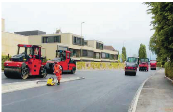
Fig 5: Posa di una pavimentazione fonoassorbente (fonte: TBA ZH)
