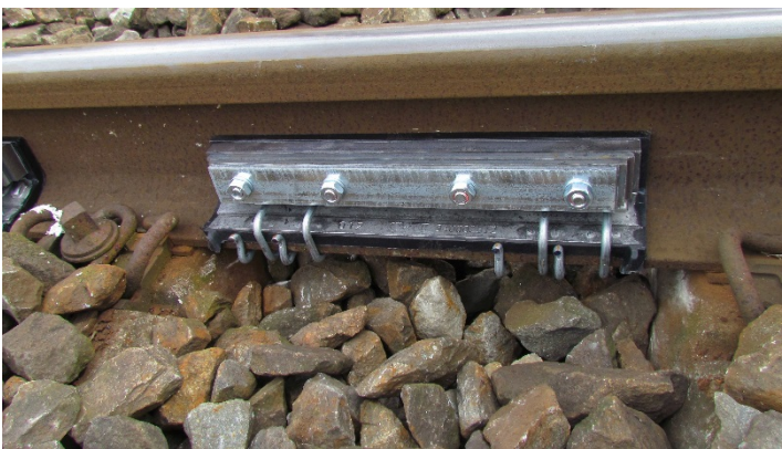
Abb. 49: Schienenstegdämpfer
