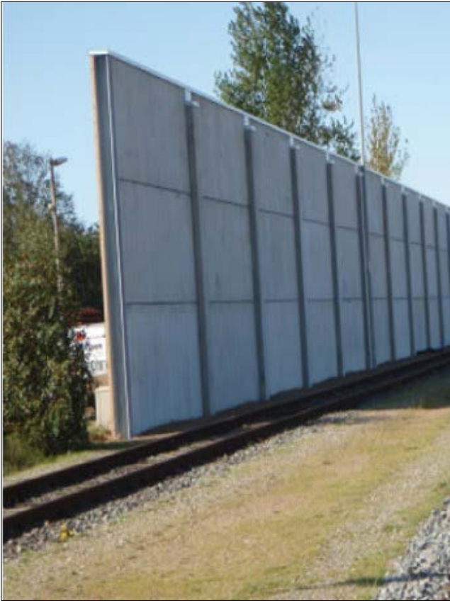
Abb. 46: Betonwand, 6,20 m hoch
