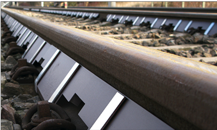
Abb. 50: Schienenstegabschirmung
