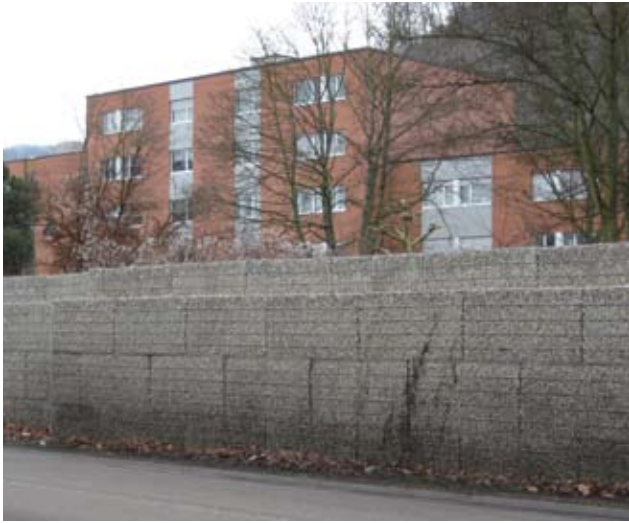
Steinkorbwand zum Schutz einer Wohnsiedlung.
