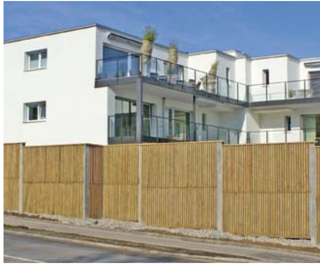
Eine Lärmschutzwand kann auch aus Holz konstruiert werden.
