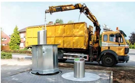
Abbildung 9: Anheben Unterflurcontainer
