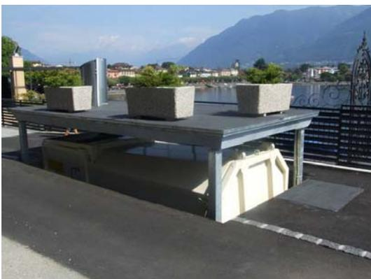
Abbildung 13: Unterflursystem auf hydraulischer Plattform mit Grosscontainer
