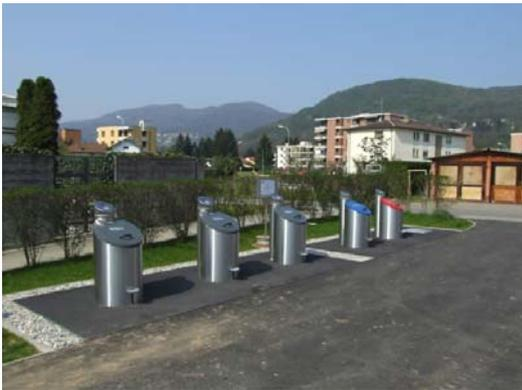
Abbildung 11: Unterflursystem auf hydraulischer Plattform mit Einzelcontainer
