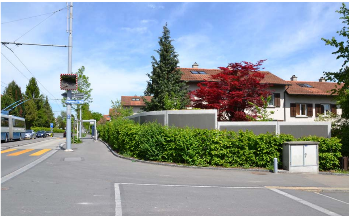
Abb. 1 Lärmschutzwand an der Schweighofstrasse
